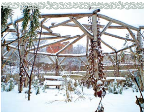
Nevada de invierno sobre la estructura de apoyo recíproco de la finca
