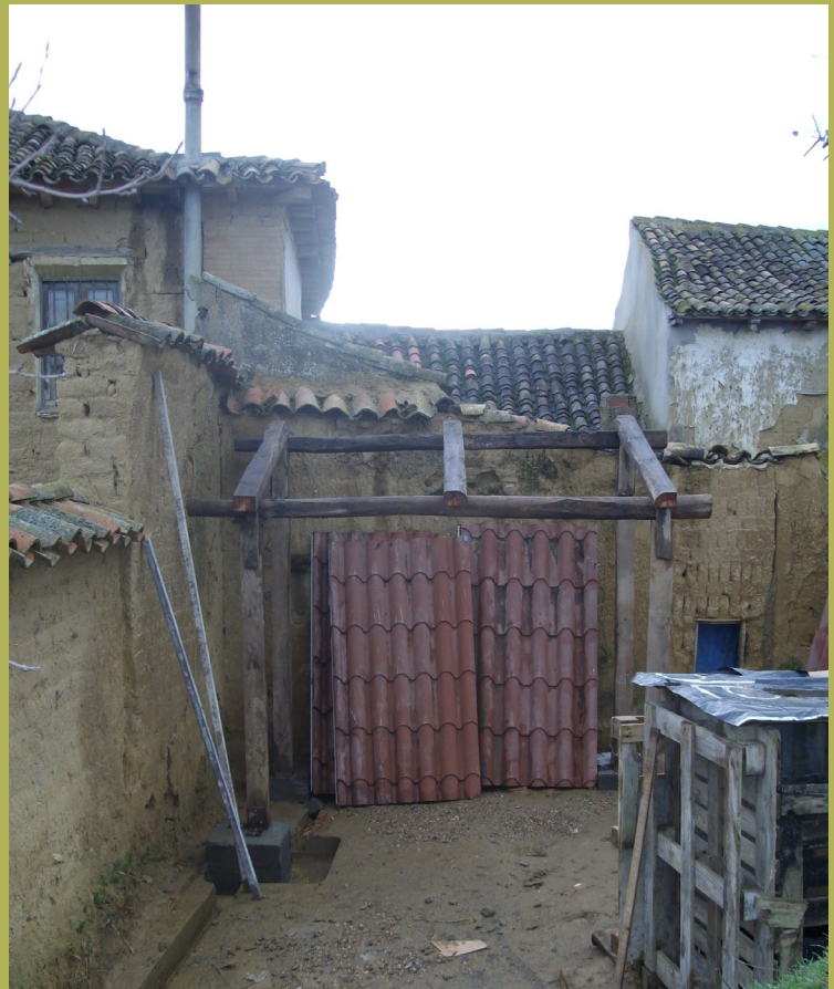
Leñero en construcción
